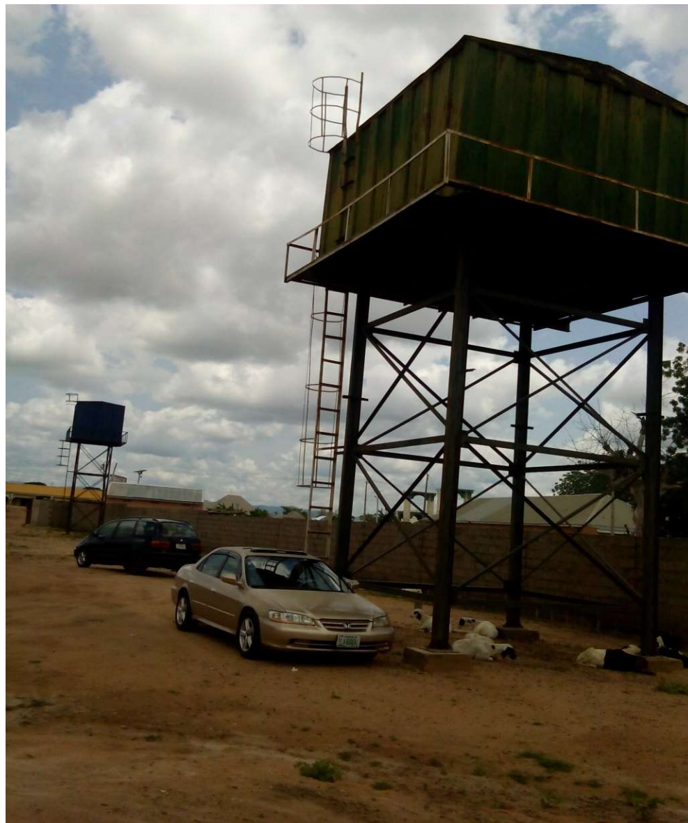
MLG project in Wuro Hausa Health Clinic (2009)
